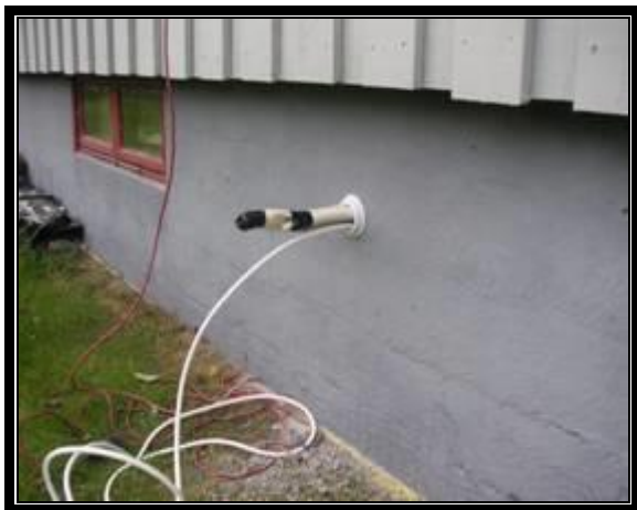
3. Rør og kabel trekkes gjennom vegg.
