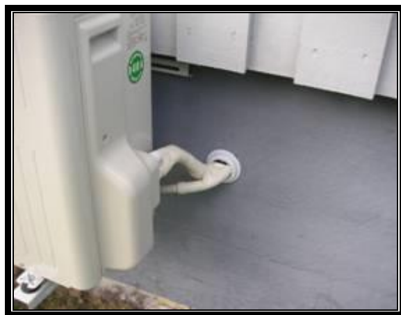
4 Tilslutt tettes røret med Trolleflex expanderende skum.
