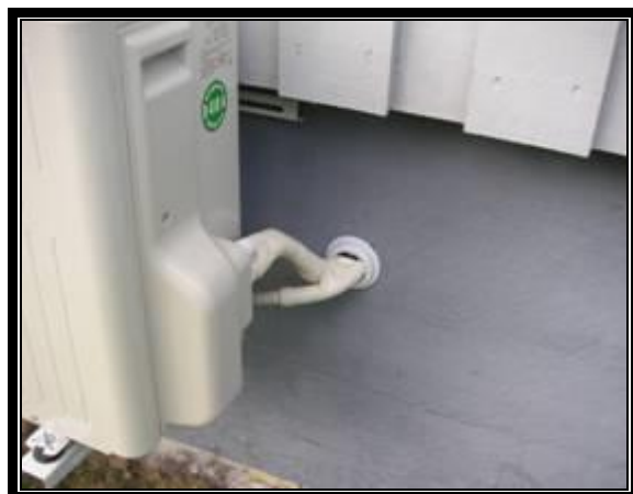
4 Tilslutt tettes røret med Trolleflex expanderende skum.
