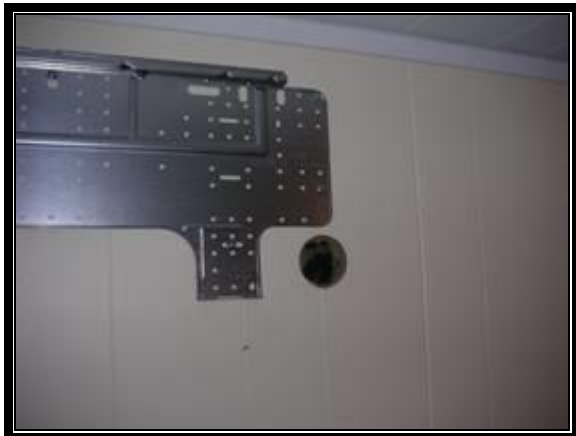
1. Monter varmepumpens bakplate. Bor så ett hull på 76mm.( husk fall ut)
