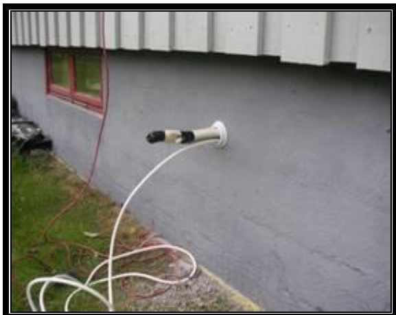
3. Rør og kabel trekkes gjennom vegg.
