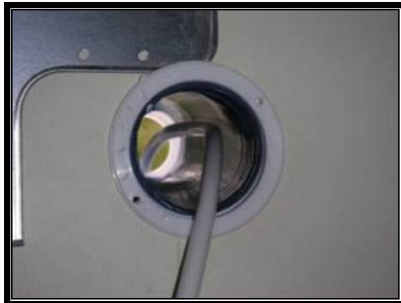
2. Tre inn Trolleflex røret, og monter mutter på inn siden ( Pass på at det blir så flatt som mulig) Monter så utvendig mutter, og stram til. Skjær så tilslutt røret av langs ytterkant mutter
